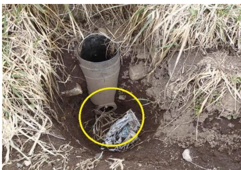
写真4 明渠からの排水が確実に圃場の外へ流れるよう、排水口を掘り下げます。ゴミなどが溜まっていると、スムーズに排水できなくなりますので、点検し、取り除きます。
