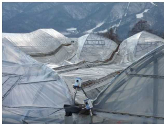
連棟パイプハウスの倒壊
