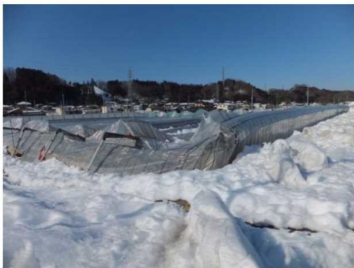
連棟パイプハウスの倒壊
