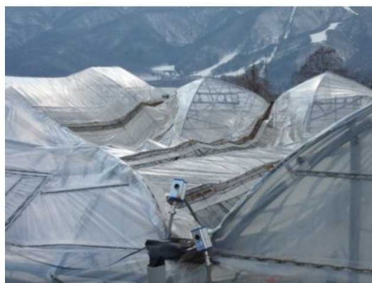
連棟パイプハウスの倒壊
