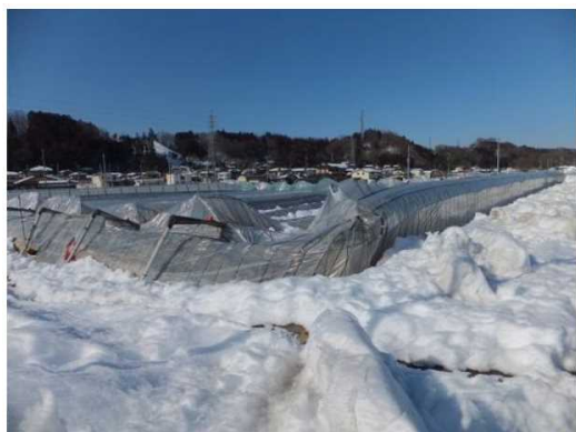
連棟パイプハウスの倒壊
