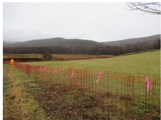
設置した高さ1m×奥行1mのワイヤーメッシュ立体柵
