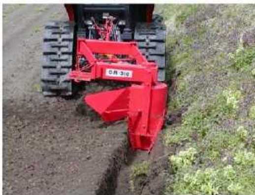
写真3 排水溝（額縁明渠）の設置 排水溝への集水は耕起土層からの流出が多いので、排水溝は耕起深より少なくとも5～10cmは深く掘ることが必要。
