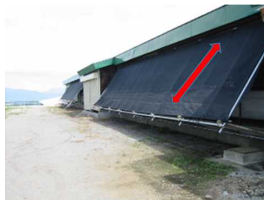
写真2 軒下へ寒冷紗を設置し西日を遮断 ※ハウスの「くるくる」を用いて巻き上げ巻き下げができる事例
