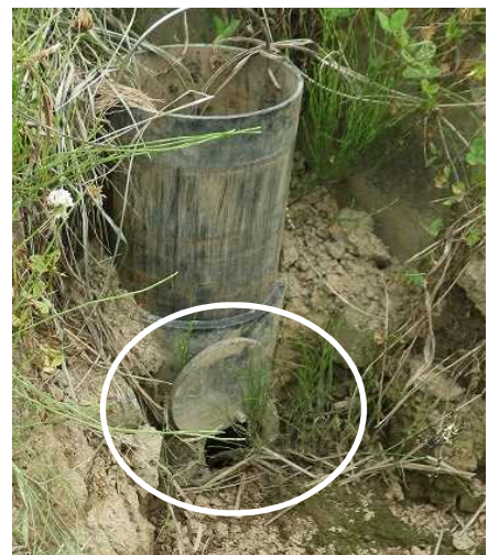
写真4 排水口まで掘り下げ
