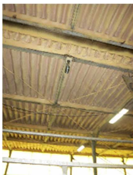
【断熱】屋根裏へのウレタン吹き付け
