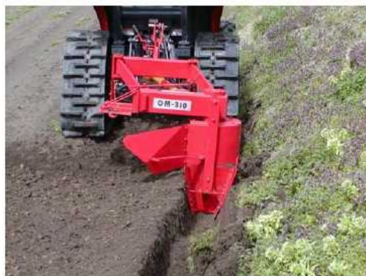
写真3 溝堀機による明渠の設置
