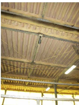
【断熱】屋根裏へのウレタン吹き付け
