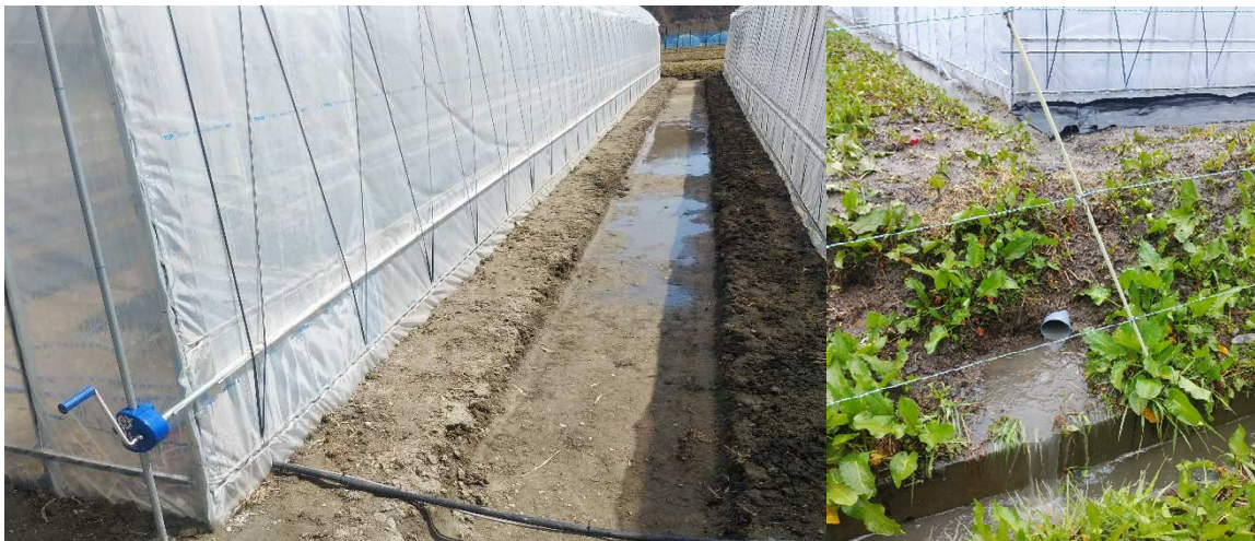
写真1 左：ハウス周囲の明渠設置状況 右：降雨時の排水路への排水状況
