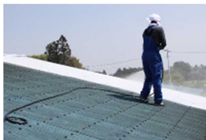
【遮熱】牛舎屋根表への石灰塗布
