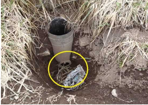
写真3 明渠からの排水が確実に圃場の外へ流れるよう、排水口を掘り下げます。ゴミなどが溜まっていると、スムーズに排水できなくなりますので、点検し、取り除きます。
