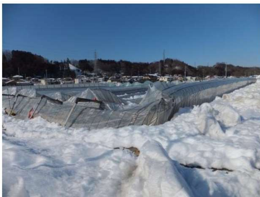
連棟パイプハウスの倒壊
