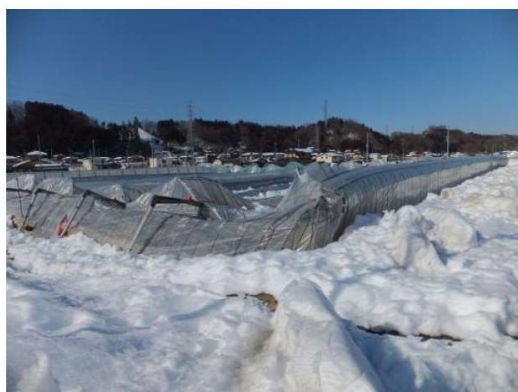
連棟パイプハウスの倒壊
