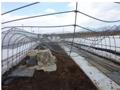
単棟パイプハウスのM字型陥没
