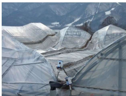
連棟パイプハウスの倒壊
