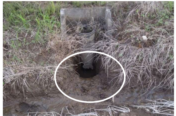
写真4 排水口の掘り下げ 水尻は大きく掘り下げ、排水溝とつなげ、フリードレーン下部から排水。
