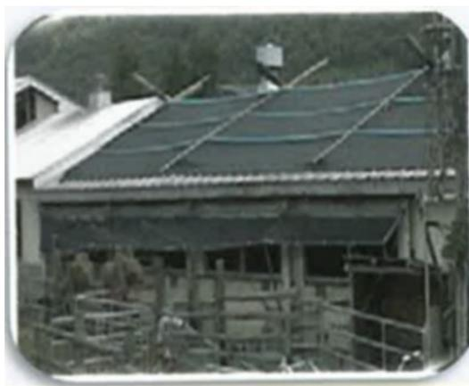
写真1 屋根表面への寒冷紗の設置
