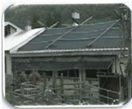
写真1 屋根表面への寒冷紗の設置 ※屋根と寒冷紗の間に角材等ですき間を設けると断熱効果が上がる
