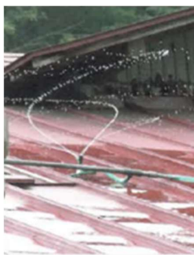
屋根表への散水
