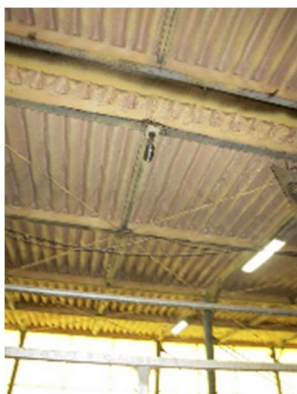
牛舎屋根裏へのウレタン吹き付け
