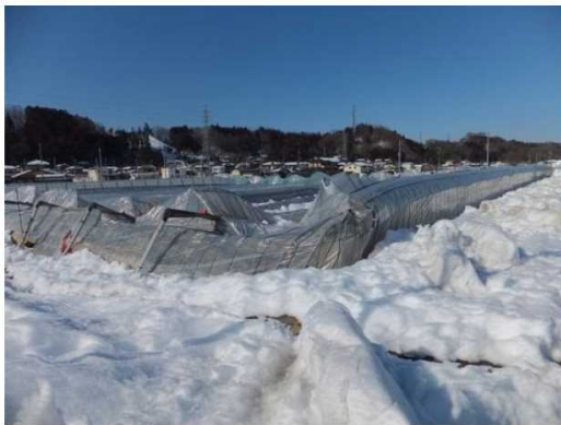
連棟パイプハウスの倒壊
