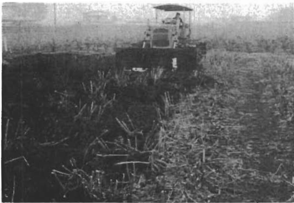
ブルドーザによる抜根状況
