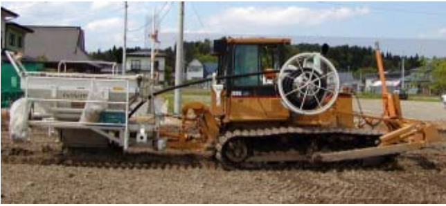
写真1 ドレンレイヤー施工状況
