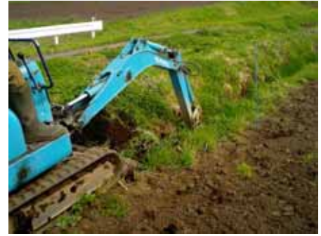
写真1 明渠施工の様子
