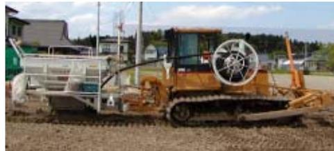
写真2 ドレンレイヤー施工状況
