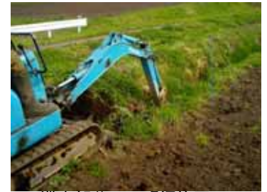
滞水部分への明渠施工
