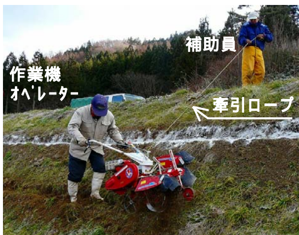
写真 2 作業道造成作業状況
