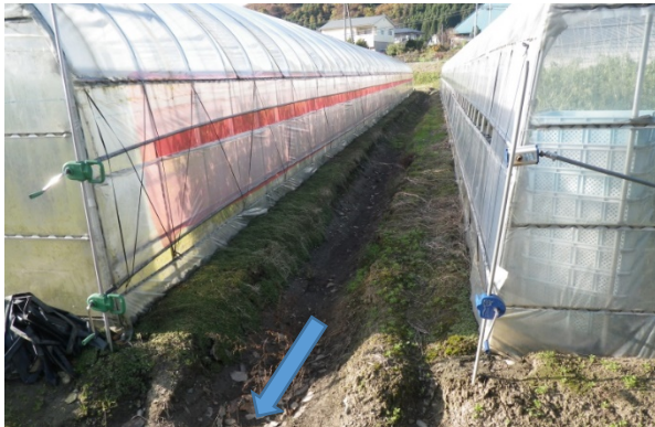
ハウス周りに深さ 20cm の明渠を設置
