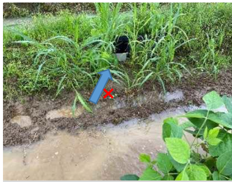
×額縁明渠が排水口へつながっていない
