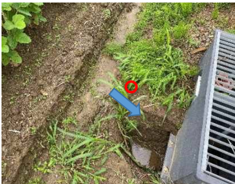
○額縁明渠が排水口へつながっている
