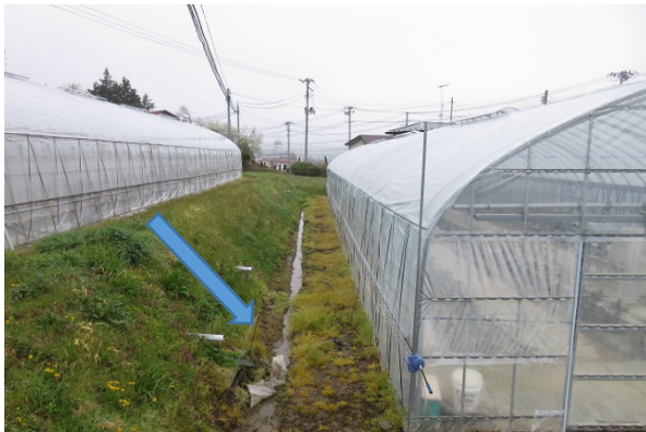
降雨時の法面からの水も明渠で排水
