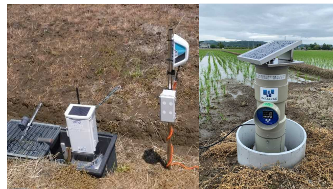
自動給水栓・水田センサー
