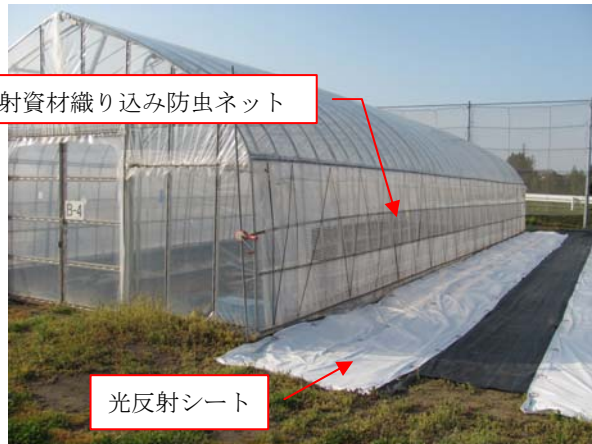
図2 物理的防除資材の展帳・敷設状況
