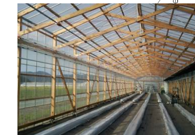
図1 木骨ハウスの特許と組上げ後の内部
