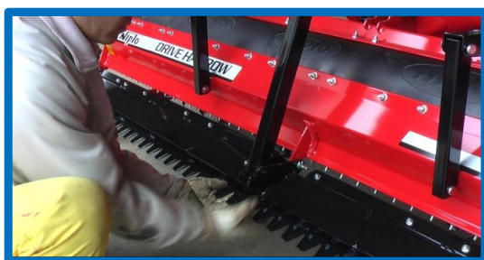
均平板の取り外し作業
