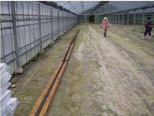
①角材等を並べ、排水溝の基礎を作る
