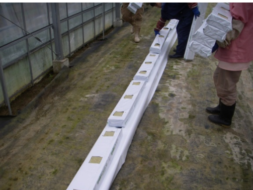
③簡易排水溝の上にロックウールを置く
