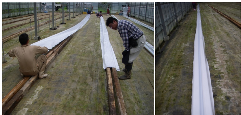
②排水溝の基礎の上に、ビニールを敷き、簡易排水溝とする
