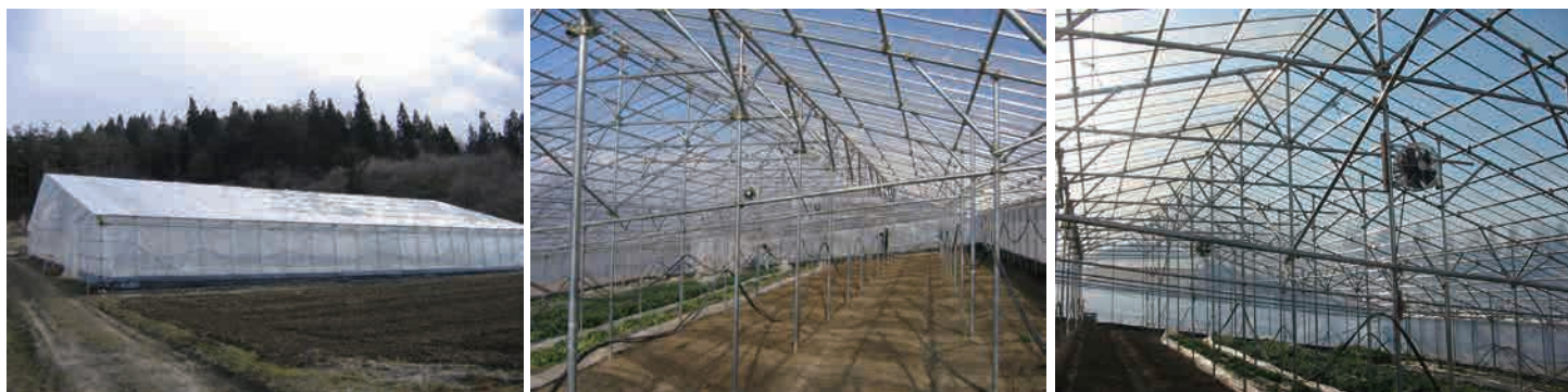
岩手県一関市：約 5.5a（屋根傾斜 15 度、圃場勾配 7 度） 県普及組織による施工
