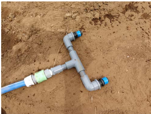
点滴チューブ接続用配管の設置
