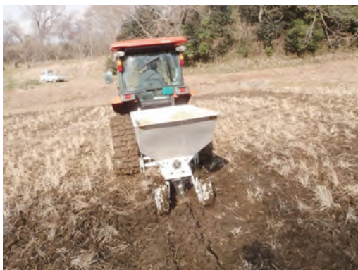
写真11 重粘土層改良機による粃殻暗渠施工作業
