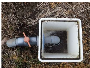
図4 地下かんがい時のバルブの開度
