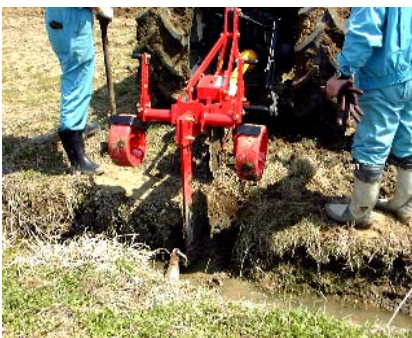
図4 弾丸暗渠施工状況
