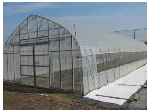
図1 光反射シートの敷設状況
