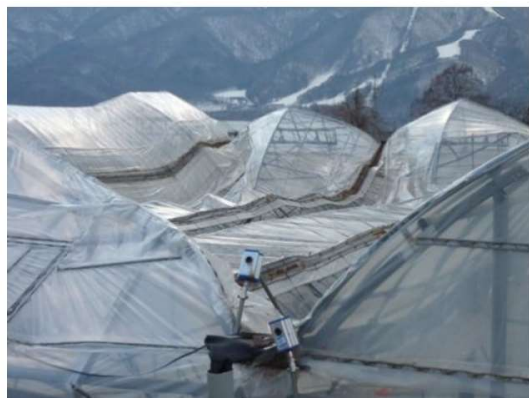
連棟パイプハウスの倒壊
