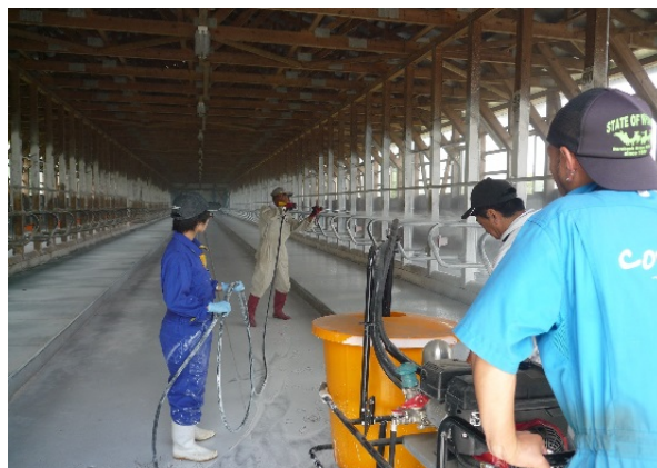
写真4 専用動噴によるドロマイト石灰の塗布作業
