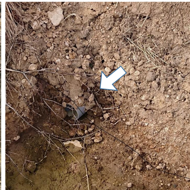
畦畔を掘り下げ、塩ビ管を埋設
