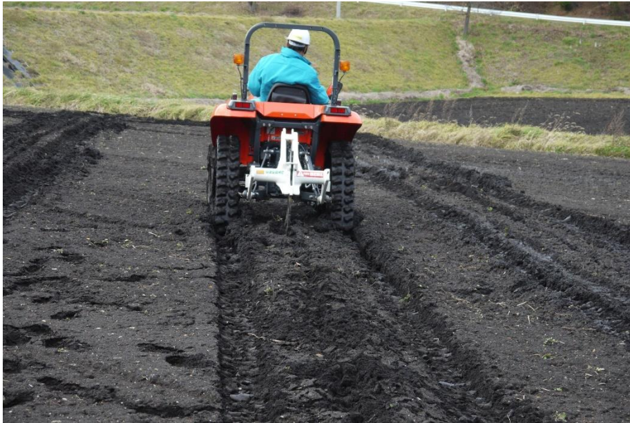
補助暗渠 サブソイラー
