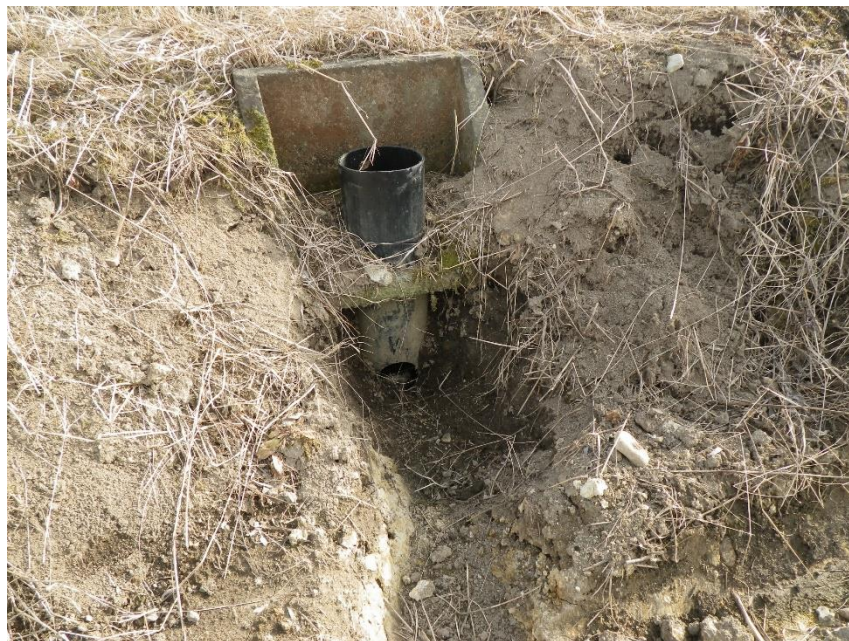
排水口と額縁明渠をつなぐ
