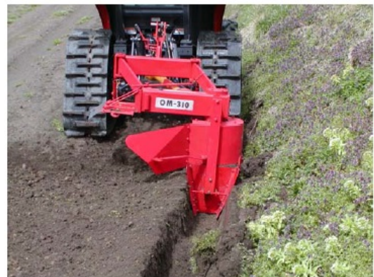
写真2 溝堀機による明渠の設置
