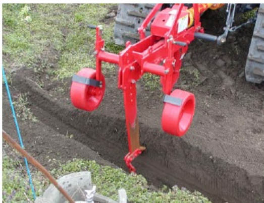
写真1 弾丸付サブソイラでの施工
