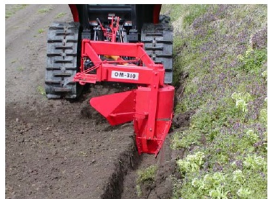
写真2 溝堀機による明渠の設置
