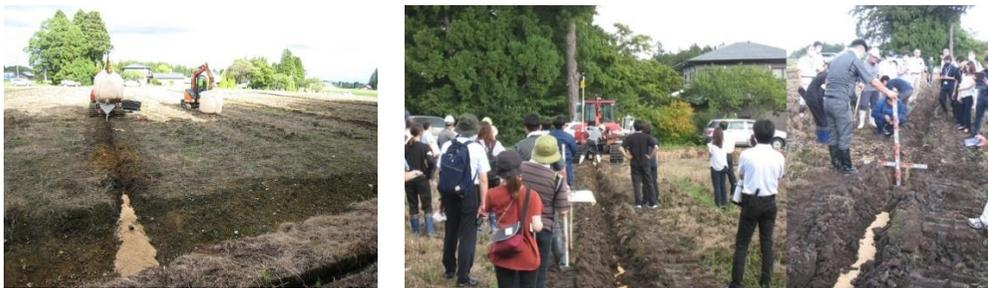
【写真 カットドレーナーによる浅層暗渠施工の状況】
