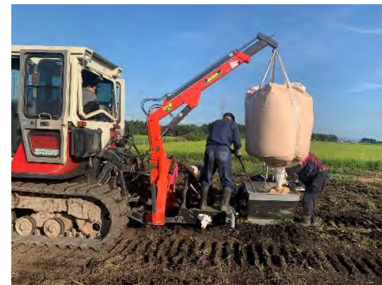
浅層暗渠施工器（約60cm深）
