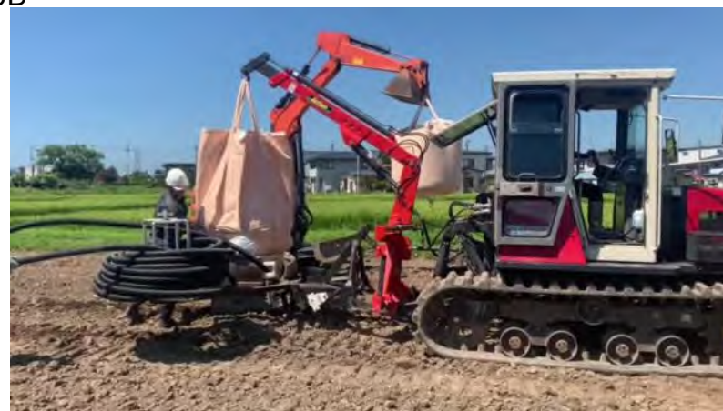
浅層暗渠施工器 作業中 動画
