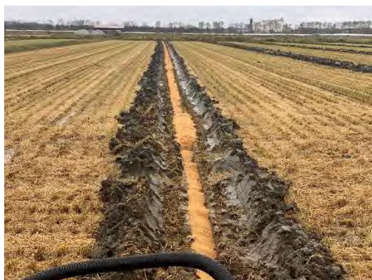
暗渠施工後の様子（OM1000A）
