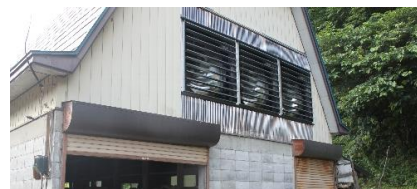
写真3 天井の低い牛舎はトンネル換気が有効です。
