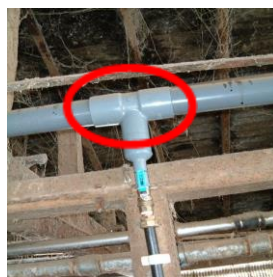
写真4 配管を太くすることで一度に十分な水量を供給できます。
