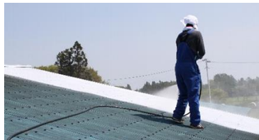
写真1 牛舎屋根への石灰塗布
