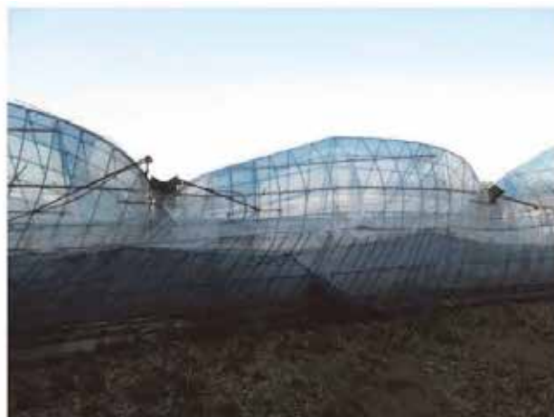
積雪と強風により横倒しに倒壊した事例
