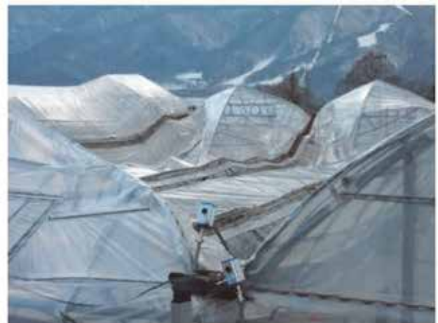
連棟パイプハウスの倒壊
