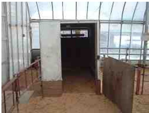
カーフハッチ内にカーボンヒータを設置した事例(カーボンヒータがいたずらされないよう、カーフハッチを高く加工)
