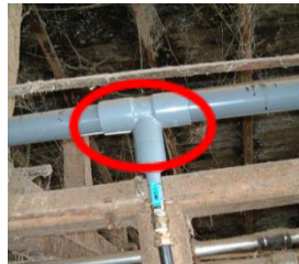
写真2 配管を太くすることで一度に十分な水量を供給できます。
