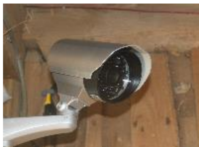
写真1 防犯カメラを活用した看視カメラ
