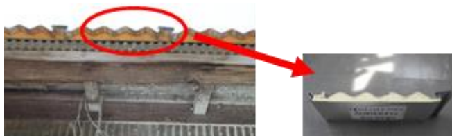
写真1 牛舎屋根への断熱材打ち付け
