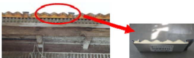
写真2 牛舎屋根への断熱材(右)打ち付け
